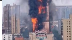
Asap Gedung terbakar
